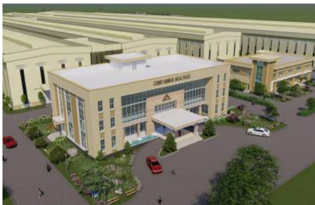
NHÀ MÁY SẢN XUẤT CONTAINER HÒA PHÁT HOA PHAT CONTAINER FACTORY
